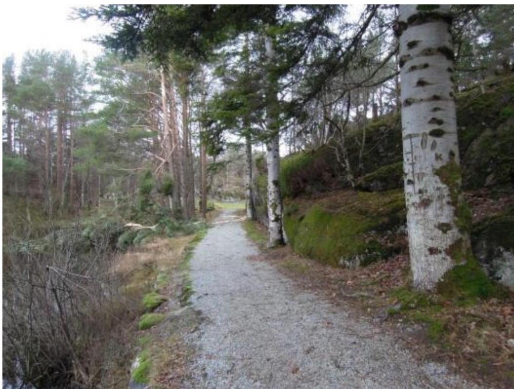
Figur 7.22. Flere edelgraner står tett langs veien ved dammen. Disse kan føre til stor skade om de velter. Ei furu har gått over ende og ligger ut i dammen.
